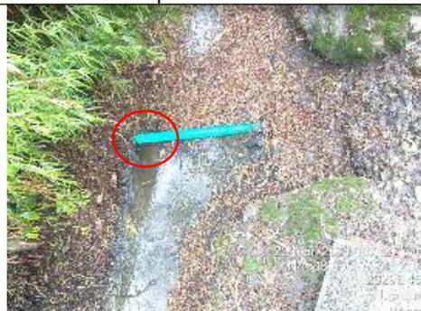
Foto 4. Tubería de descarga de ARD tratada.
